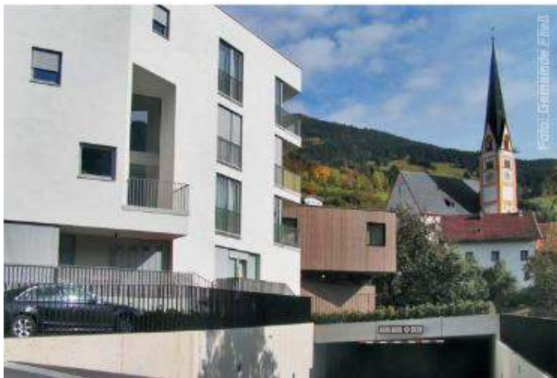
Abbildung 53: Neues Wohngebäude im Ortskern von Fließ (Quelle: Agrarsoziale Gesellschaft 2016)
